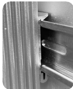
已安裝在導軌上
